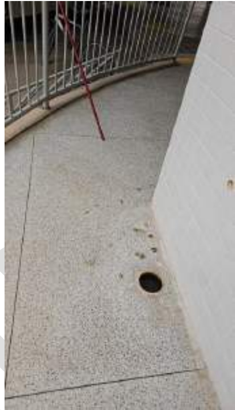
Imagem 27 - Ralo sem Tampa, risco de acidente.
